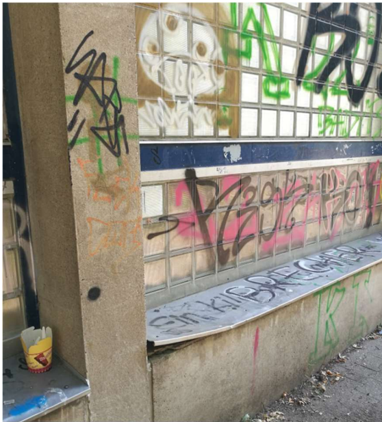
Schäden an Glasbausteinen
