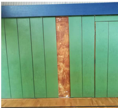
Schäden Prallwände
