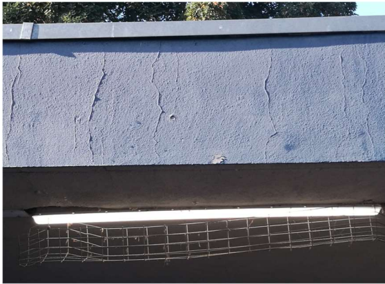
Schäden an Dach und Attika
